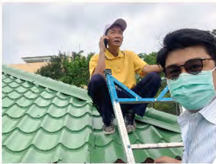
▲ 查看屋頂油漆情形
