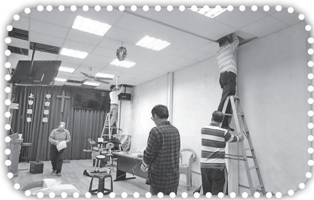
▲弟兄架設電視及音響設備。
